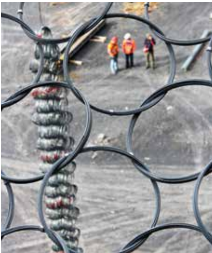
Ein Netzing besteht aus bis zu 19 Drahtwindungen: So kann maximale Sicherheit gewährleistet werden.
